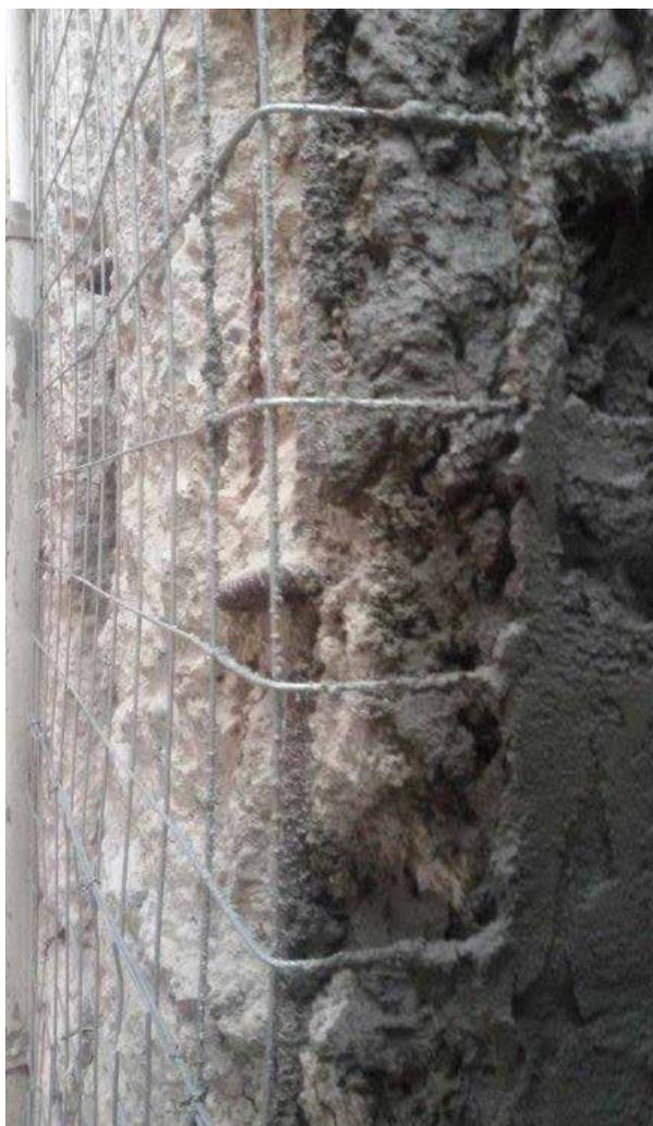
Ripristino e rinforzo delle murature in un sottopasso eseguito con armatura in rete metallica elettrosaldata a maglie larghe e riempimento con **Restaurmix K05 F**, malta premiscelata a secco.
